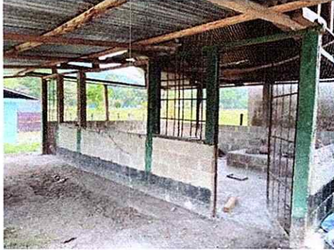
Foto1: CUBIERTA DE LAMINA
