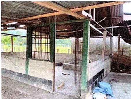
Foto 3: ESTRUCTURA DE TECHO
