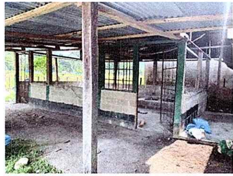
Foto 2: EL CORREDOR TIENE 3 METROS Y SE HARA DE COLUMNAS DE CONCRETO CON TUBOS CUADRADOS.
